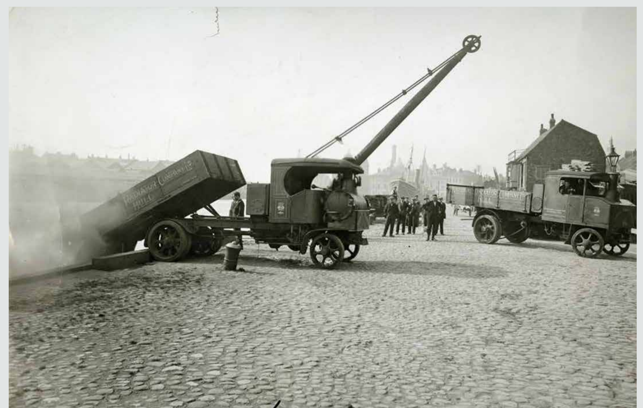
Заполнение дока Queens Dock в Халле, 1930 г. На этом изображении показан процесс разгрузки грузовиков компании National Radiator Company Ltd.
